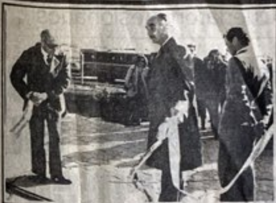
El intendente Fabrizio y el ingeniero Castro cortan las cintas que habilitan las nuevas instalaciones, en el Parque Industrial.
