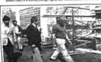
El director de Planeamiento y Desarrollo de la Municipalidad, Salviador Fazio, recorre las obras en marzo de 1980, al anunciar que se pondría en marcha la segunda etapa.
