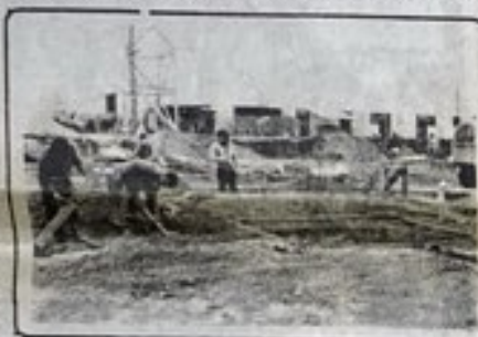
Con buen ritmo continúan las obras de construcción en el Parque Industrial de Mar del Plata.
