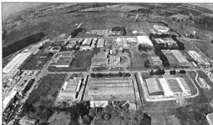
Vista panorámica del parque industrial "General Savio", que nuclea sesenta establecimientos y 4.000 puestos de trabajo.
