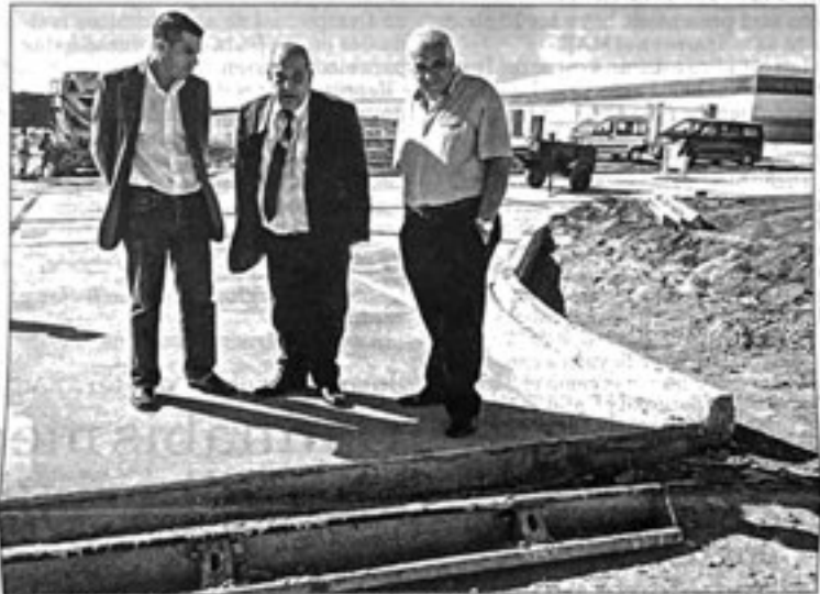
El intendente Carlos Fernando Arroyo valoró las tareas que mejorarán la interrelación entre las empresas mientras recorría obras de asfalto en el Parque Industrial.
