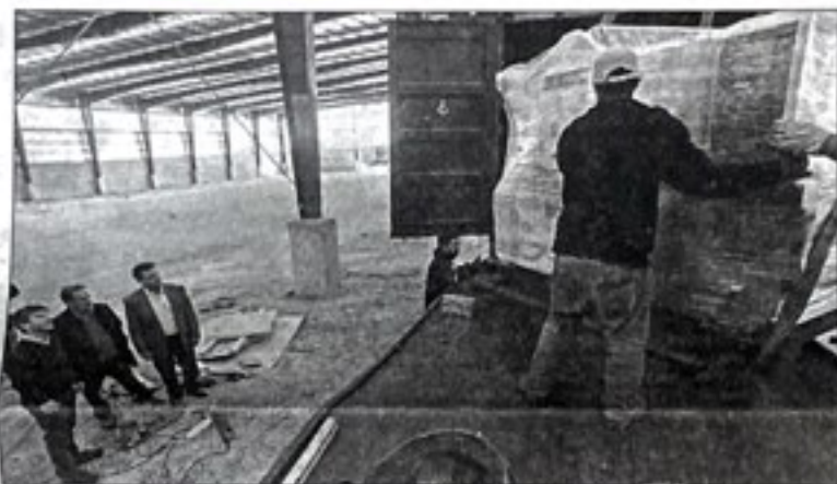
La empresa recibió 20 contenedores con maquinarias para su funcionamiento.
