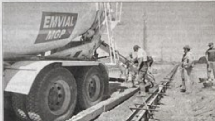
A la espera del crédito para ampliar las instalaciones del parque, Vialidad municipal trabaja en la pavimentación de las calles del predio.
