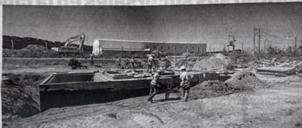
Avanzan las obras de ampliación en el Parque Industrial.
