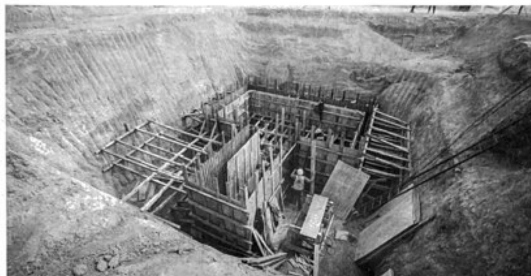
Ejecutan importantes obras de infraestructura en el Parque Industrial "General Savio".
