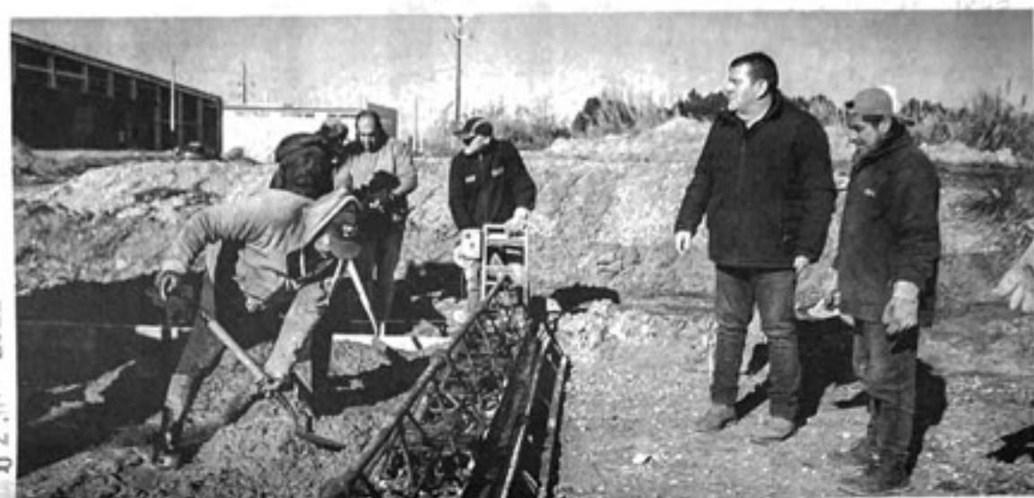
Montenegro supervisó las obras en las nuevas calles del Parque Industrial.
