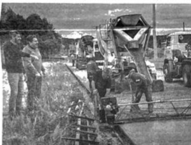
Montenegro recorrió las obras que se realizan para facilitar la radicación de empresas.
