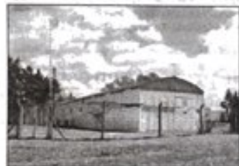
Canadian Nutrition S.A. está poniendo en funcionamiento una vieja planta de carpintería en aluminio.
