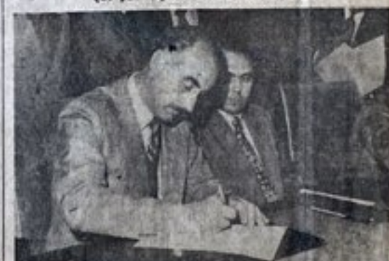
El intendente municipal marplatense rubrica el contrato por el que se asigna una partida de refuerzo para las obras del Parque Industrial.
