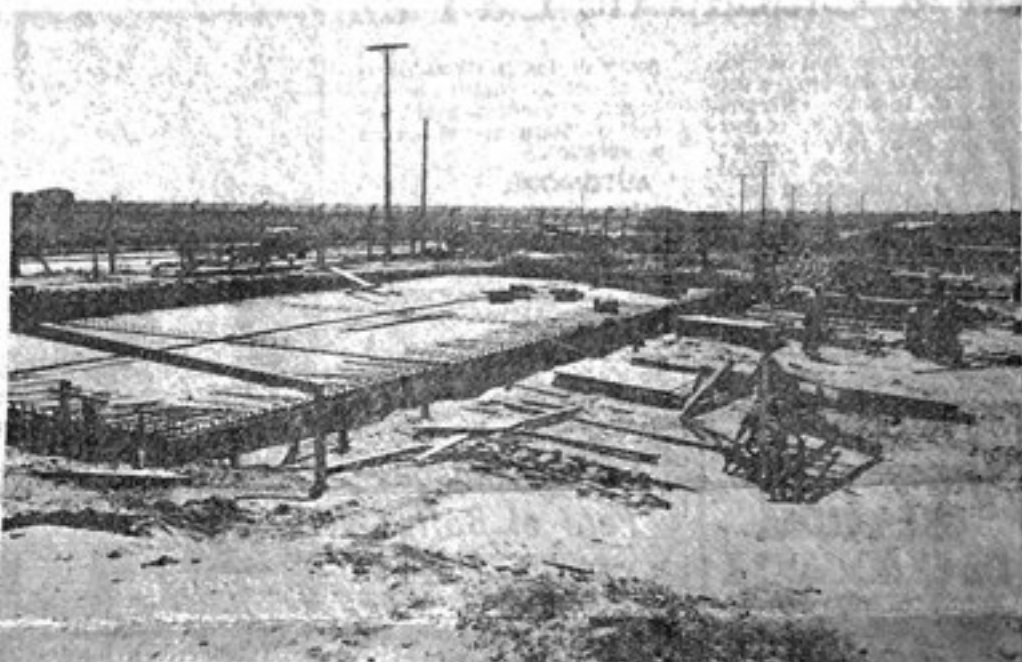
La futura planta elaboradora de pescado, ya tiene su basamento. Se instalará en el Parque Industrial y será la primera, a estar del ritmo impuesto a los trabajos de construcción que se están llevando a cabo.
